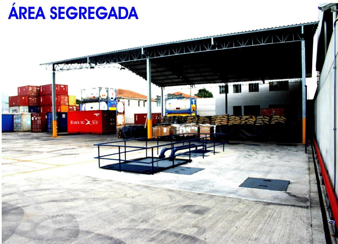
Foto 3 - Sistema de contenção de drenagem da Área de Segregação.
