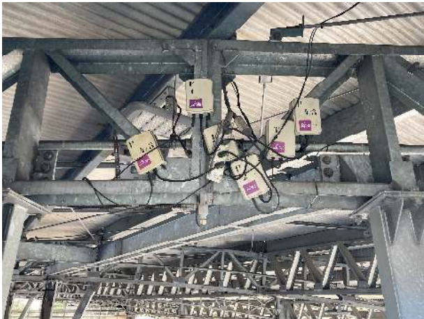
Figura 15: vista dos dispositivos para afugentar aves.
