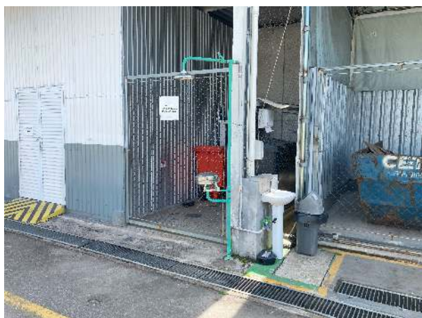
Figura 22: vista do local destinado a estocagem de resíduos perigosos.
