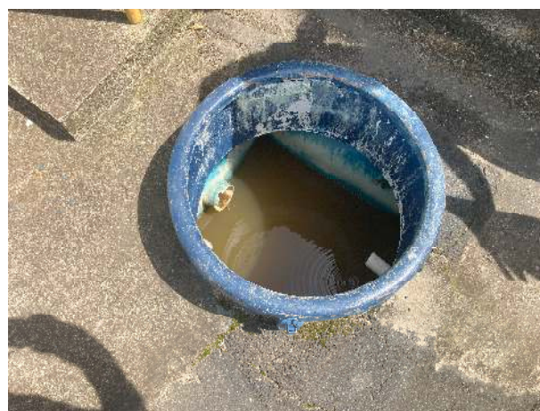
Figura 24: vista do líquido gerado na ETE 02.
