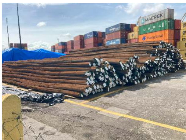
Figura 27: vista da área de estocagem de vergalhões.
