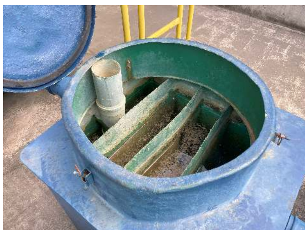
Figura 25: vista do líquido gerado na ETE 04.
