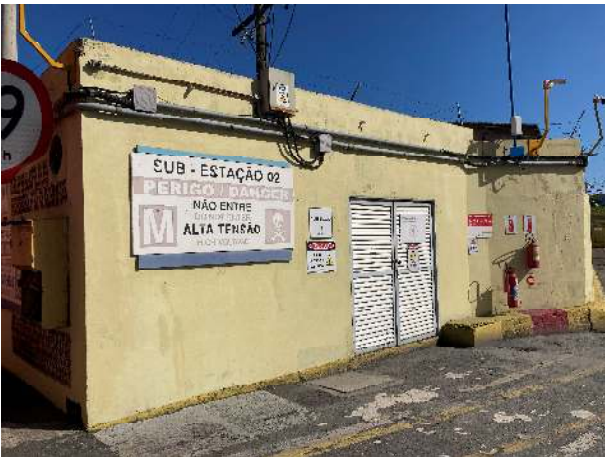
Figura 14: vista de uma das Subestações visitada.
