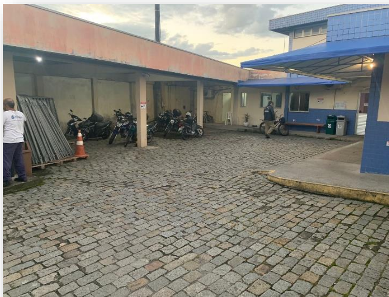
Figura 6 Espaço interno do estacionamento da edificação da COSEG
