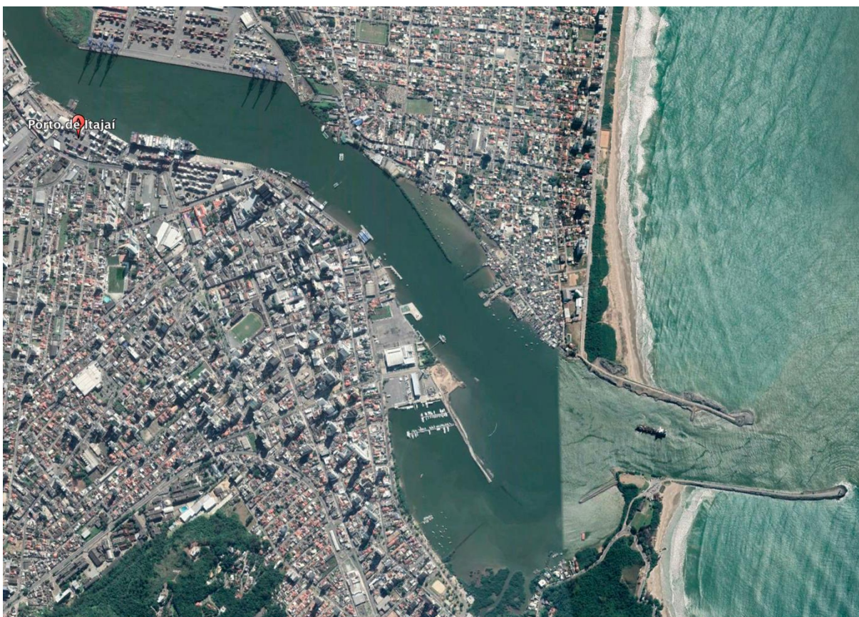
Figura 1-5 – Estruturas e obras de apoio e segurança da navegação
