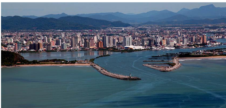
Figura 5-22 – Estruturas artificiais abrigadas (face interna) e expostas (face externa) – Molhes do Porto de Itajaí
