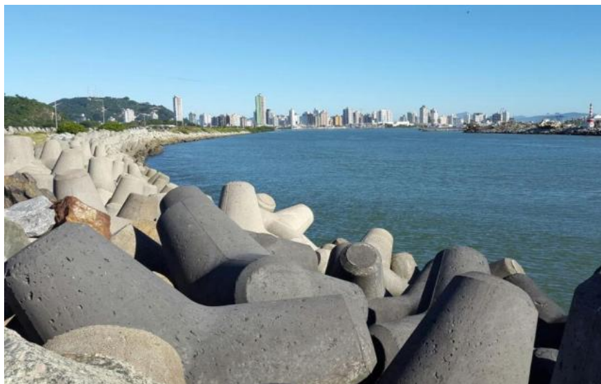
Figura 5-23 – Estruturas artificiais abrigadas e expostas – Tetrápodes nos molhes do Porto de Itajaí
