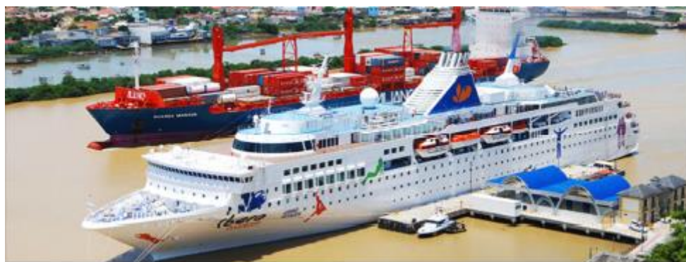
Figura 1-8 – Vista do Terminal de Passageiros
