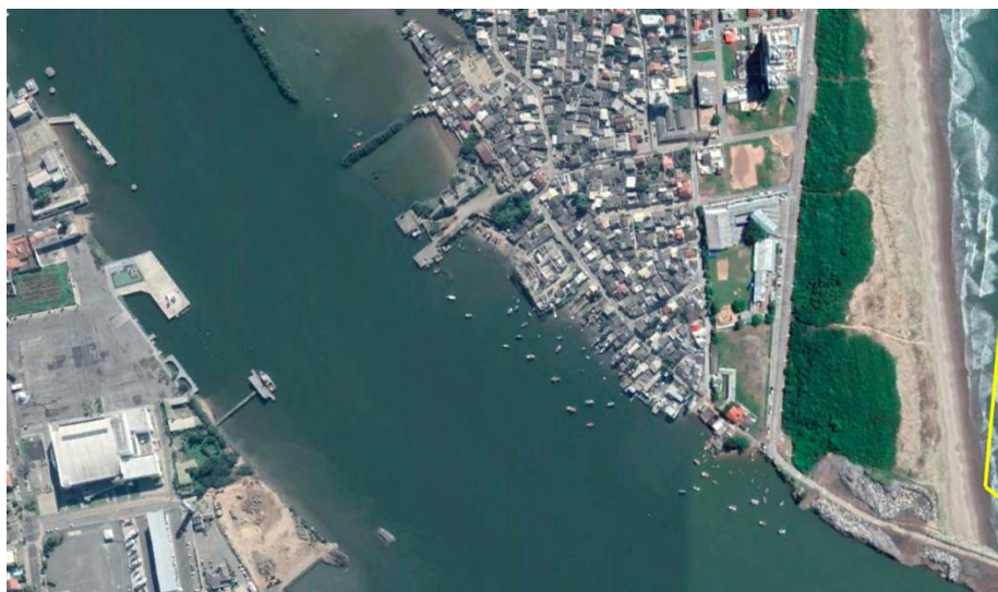
Figura 5-28 – Estruturas de apoio náutico e embarcações de pesca presentes na margem esquerda do rio Itajaí-Açu, defronte ao Porto de Itajaí. Áreas prioritárias para as ações de proteção da população.
