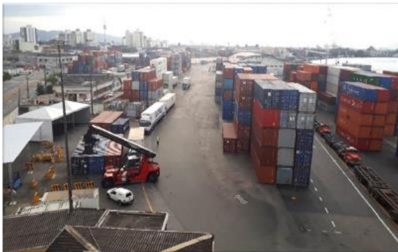
Figura 1-13 – Vista geral do Porto Público
