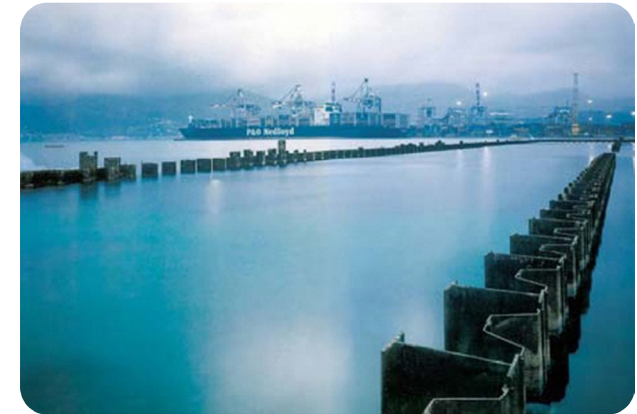
Figura 11. Imagem ilustrativa da estrutura de contenção a ser utilizada: estaca-prancha. Fonte: Google Imagens, 2013.
