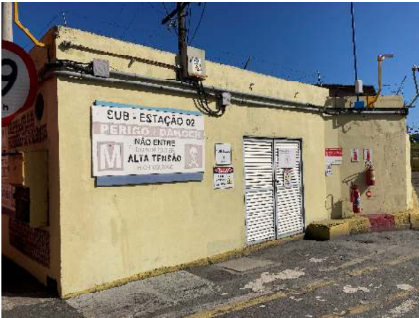
Figura 14: vista de uma das Subestações visitada.
