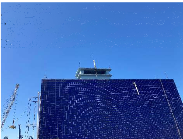
Figura 16: vista de dispositivos para raios.
