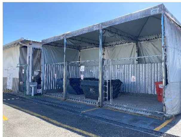
Figura 20: vista do local de estocagem temporária dos materiais recicláveis.
