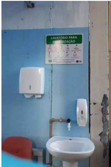
Figura 82 - Instalação de lavatório no Armazém 03 – Área Portuária – 1º semestre de 2020.
