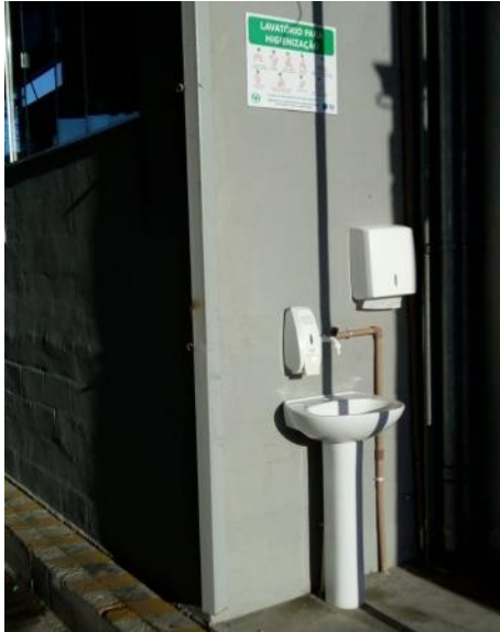
Figura 78 - Instalação de lavatório no Gate II – Área Portuária
