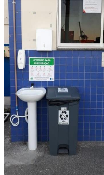
Figura 79 - Instalação de lavatório na balança/RAC – Área Portuária.
