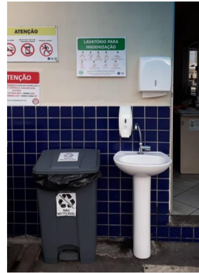
Figura 83 - Instalação de lavatório no RAC – Área Portuária – 1º semestre de 2020.
