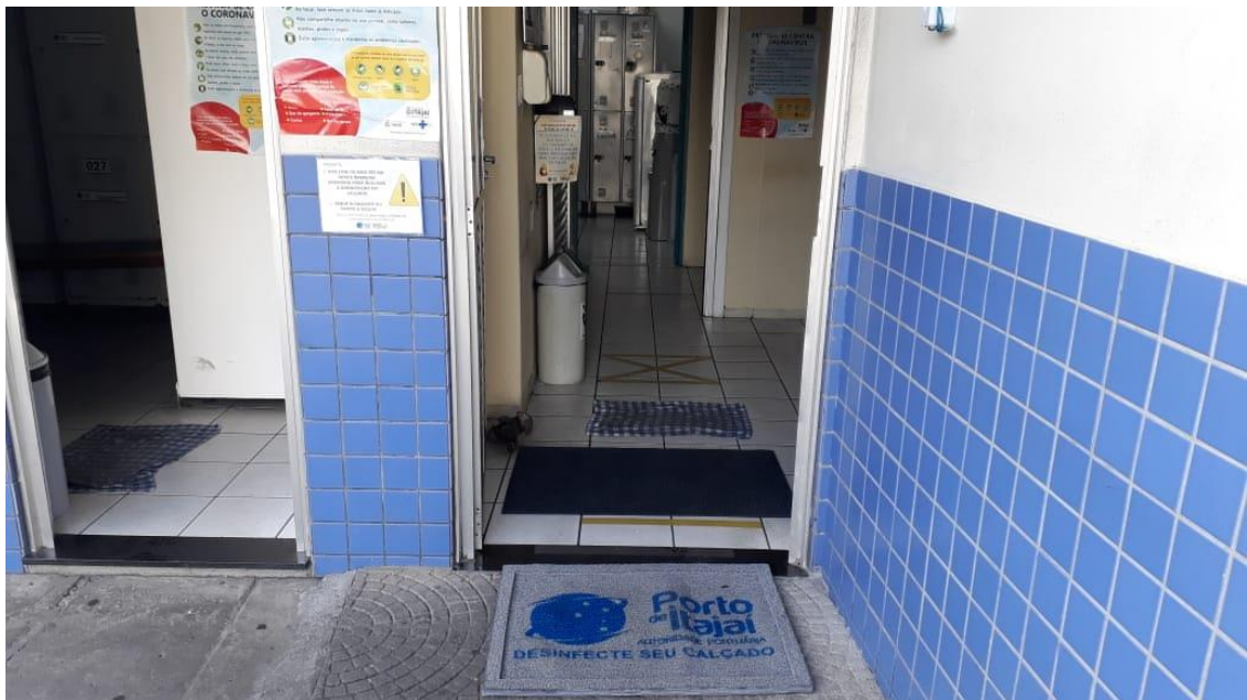
Figura 60 – Instalação de tapetes de desinfecção no Prédio da Guarda Portuária.
