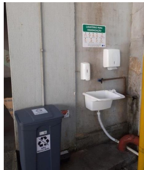
Figura 81 - Instalação de lavatório na Vale Port – Área Portuária
