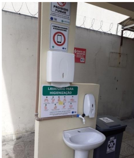
Figura 80 - Instalação de lavatório no Portão de Acesso – Área Portuária
