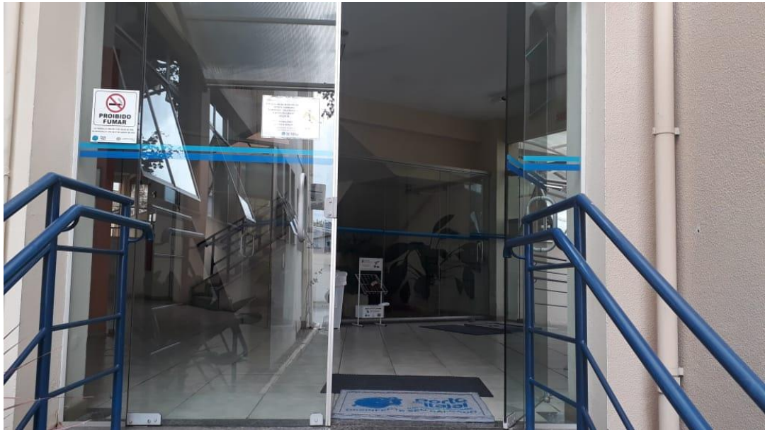
Figura 54 – Instalação de tapetes de desinfecção no Prédio Administrativo.
